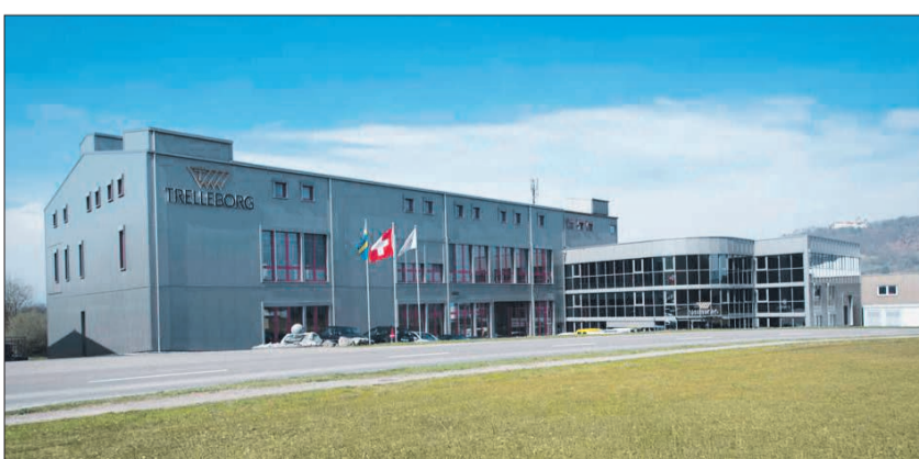
Ausbau Trelleborg Sealing Solutions Silcotech Switzerland AG, Erweiterung Fabrikationshalle mit Reinraumproduktion sowie Aufstocken des Bürogebäudes.
