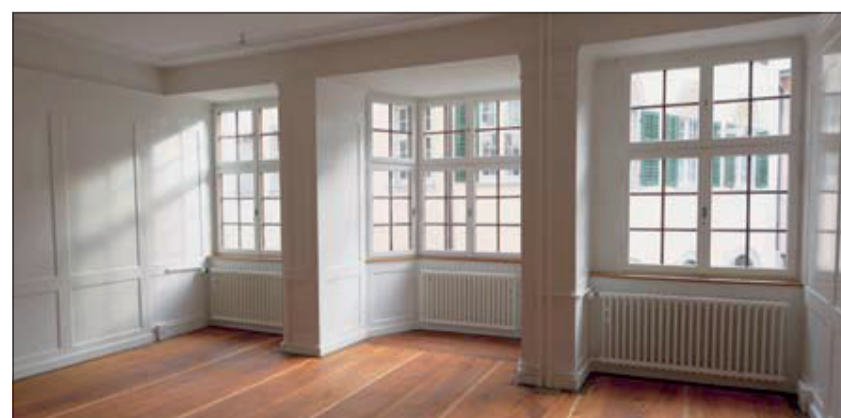
Umbau/Sanierung Haus zur Wasserquelle in der Altstadt Schaffhausen. Architektur Reich Bächtold Architekten, Bauleitung s+p.
